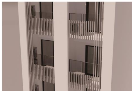
陽台外緣設置垂直格柵/牆體/造型
